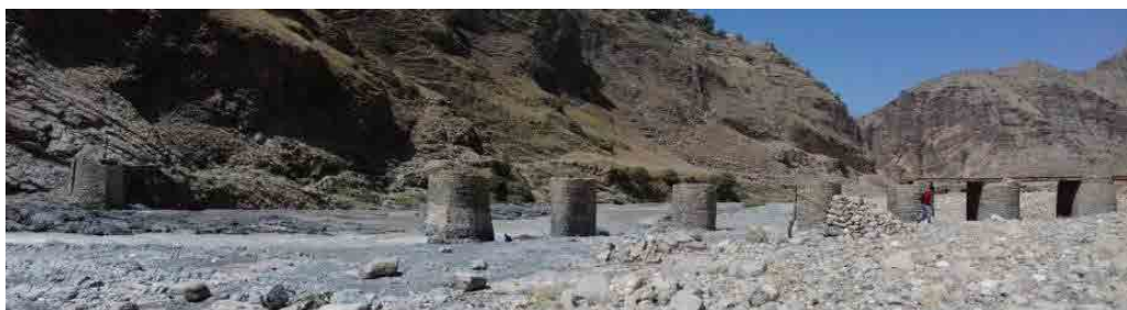
تصویر ۷. نمای از پل شماره ۲ نوم کول. دید از شرق (نگارنده، ۱۳۹۸). Fig. 7. View of Nomkol Bridge No. 2. View from the East (Author, 2018).
