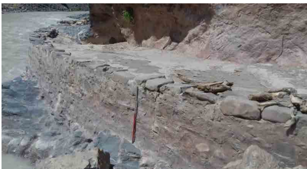
تصویر ۱۸. ایجاد دیوار در حاشیه رودخانه برای ایجاد راه عبور (نگارنده، ۱۳۹۸).
