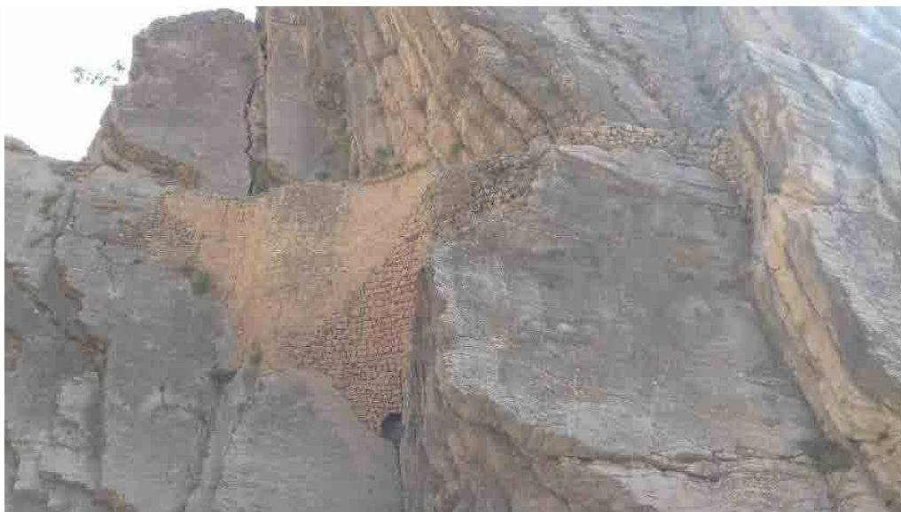
تصویر ۱۵. ایجاد دیوار در بدنه صخره برای راه عبور (نگارنده، ۱۳۹۸).
